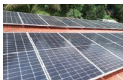
保育所の屋根にソーラーパネルを設置
