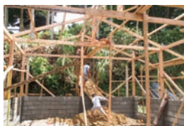
建設中の保育所
