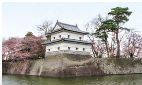
新発田城 旧二の丸隅櫓 櫓の腰壁は白いつくいに瓦をはめ込んだ海鼠壁で仕上げられている。北国特有の防寒対策でもあるが、デザイン的にも白と黒のコントラストが美しい
