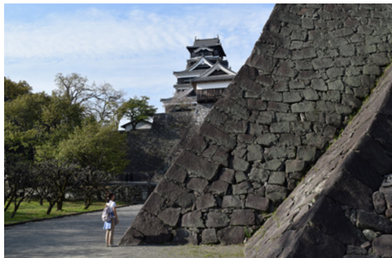
「扇の勾配」という技法を使った石垣は曲線が美しいだけでなく、安定感にも優れています
