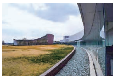
池と造形的盛土で囲まれた建物は水面に浮かび上がる島をイメージしている
